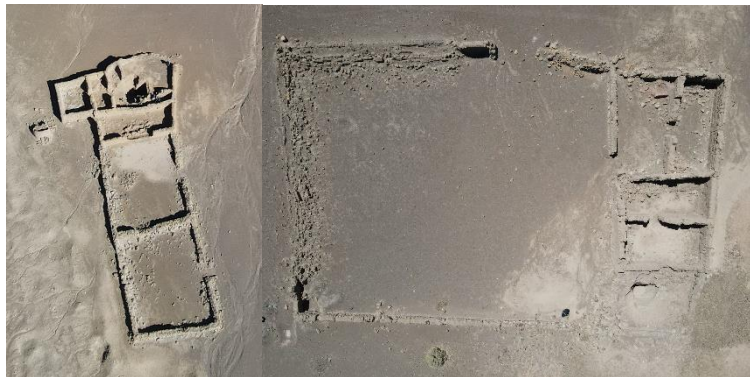
Figura 33: Edificaciones en sector 1. Izq. Habitacional con corrales. Der. Complejo remesero. Fuente: FONDECYT 1190023
