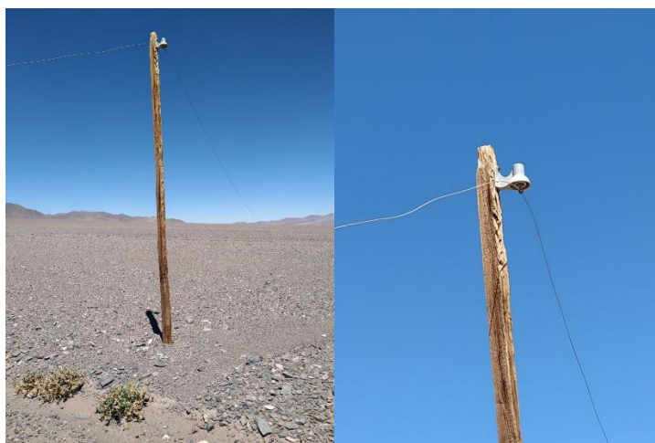
Figura 30: Telégrafo en pie, PM 75. Izq: Vista total del poste. Der: detalle de soporte que sostiene el cable telegráfico. Fuente: FONDECYT 1190023
