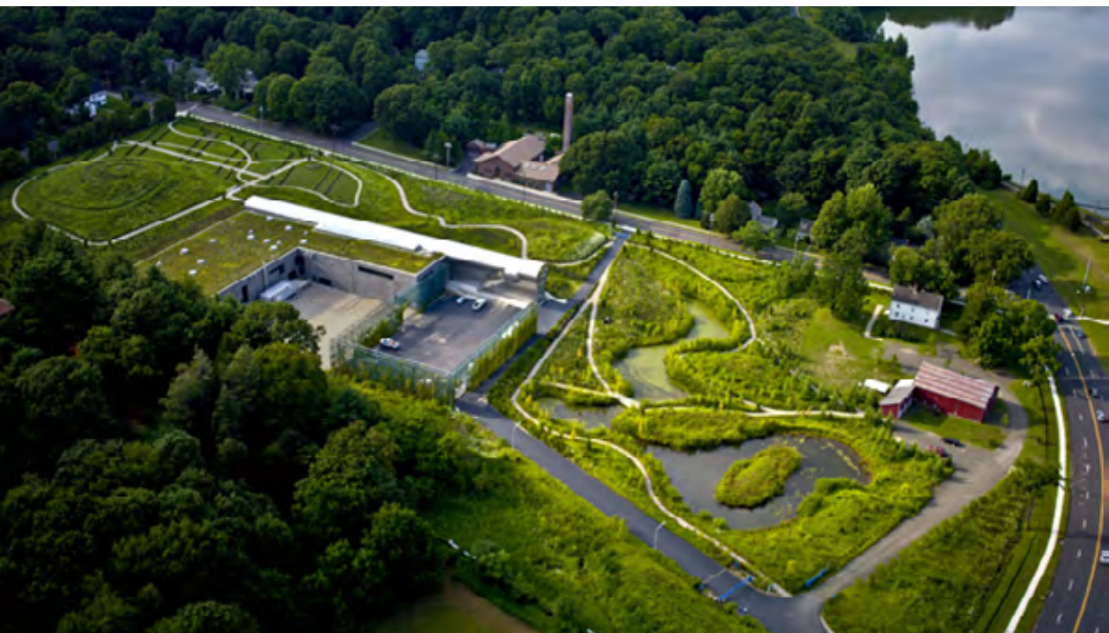
Imagen 23: Planta de tratamiento de aguas y Parque de Whitne Fuente: arquitecturaenacero.org
