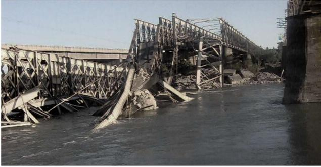
Imagen 5: Fotografía de puente carretero Maule colapsado, dos días después del sismo de baja intensidad ocurrido durante la madrugada del 20 de febrero del 2006.
