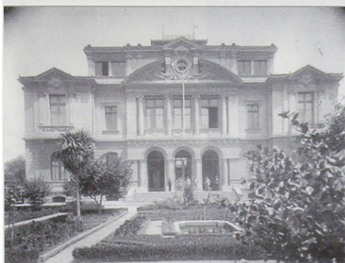
Edificio de Sanidad de calles Independencia y General Borgoño.
