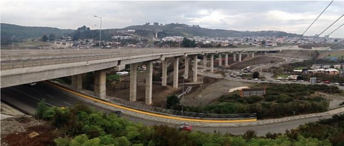
Ilustración 22 Viaducto de Conexión Inter terrazas.
