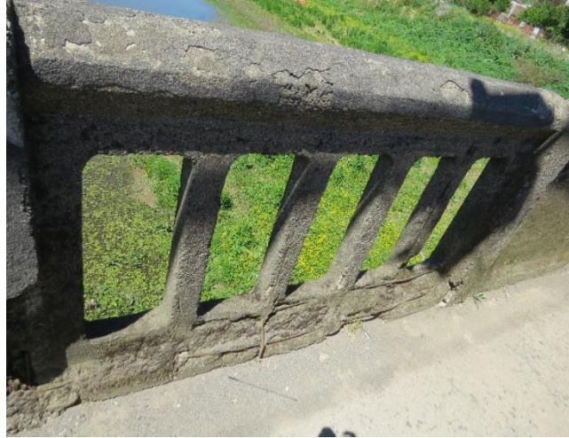
Figura 8. Baranda exterior del Puente Andalién con el parte de sus balaustres rectangulares y barandilla de bordes limados. (Concepción, Chile). Autor. Marcelo Bravo, 2021.
