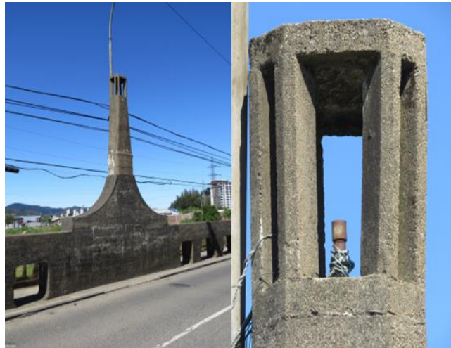
Figura 10. Una de las imponentes luminarias del Puente Andalién, con el detalle de su farol de chapitel de canto limado, con el soquete del inaugural alumbrado a gas que poseía este viaducto. (Concepción, Chile). Autor. Marcelo Bravo, 2021.
