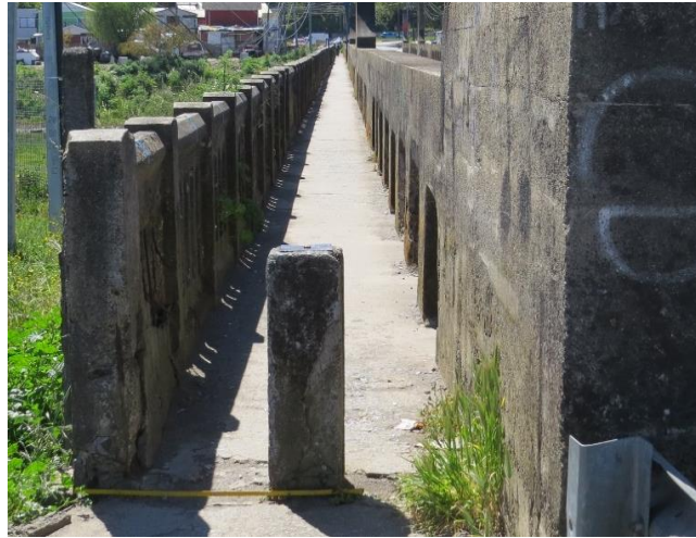
Figura 12. Remanente de uno de los torniquetes del Puente Andalién, con el cual se controlaba el acceso peatonal. (Concepción, Chile). Autor. Marcelo Bravo, 2021.
