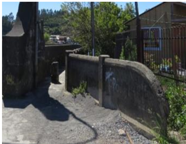
Figura 13. Muro perimetral de Puente Andalién, que proyecta a este viaducto con la calle Camilo Henríquez. (Concepción, Chile). Autor. Marcelo Bravo, 2021.
