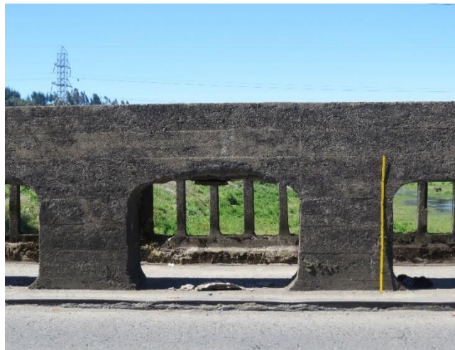
Figura 9. Baranda interna del Puente Andalién, que muestra las aberturas en forma de cuadrados con vértices redondeados. (Concepción, Chile). Autor. Marcelo Bravo, 2021.
