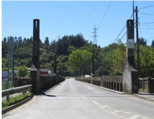
Figura 7. Fotografía que muestra los senderos peatonales laterales y calzada central vehicular del Puente Andalién. (Concepción, Chile). Autor. Marcelo Bravo, 2021.
