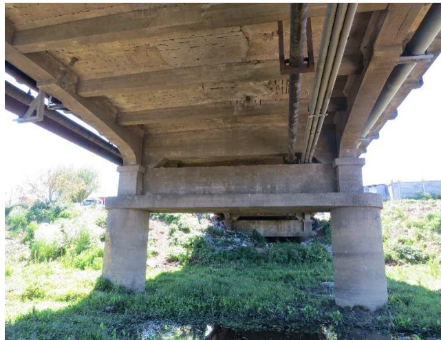
Figura 11. Sistema de pilotes y cepas que sostienen al tradicional Puente Andalién. (Concepción, Chile). Autor. Marcelo Bravo, 2021.
