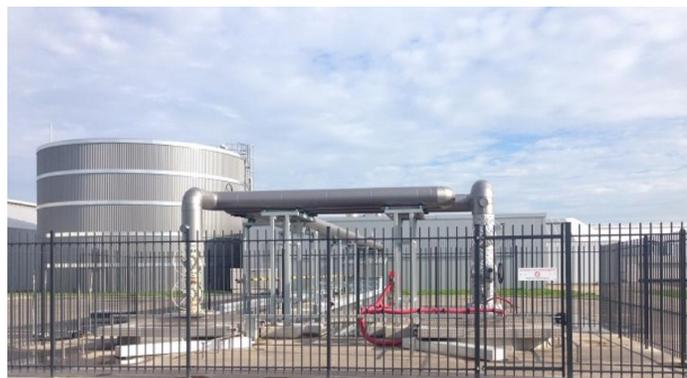
Figura 8: Sistema de perforación y obtención de calor geotérmico en Heemskerk Floricultura (Fuente: Floricultura, 2022).
