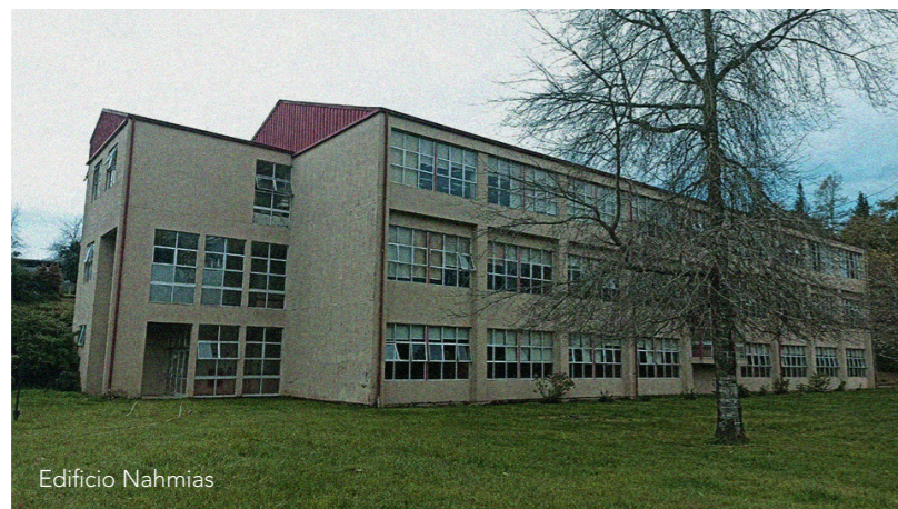
Fig. 32. Frontis Edificio Nahmias Universidad Austral de Chile. FUENTE: Kataly Qvanstrom, 2022.
