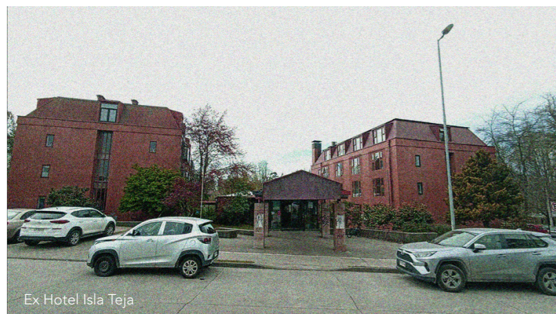
Fig. 33. Frontis desde calle Las Encinas del Ex Hotel Isla Teja. FUENTE: Kataly Qvanstrom, 2022.
