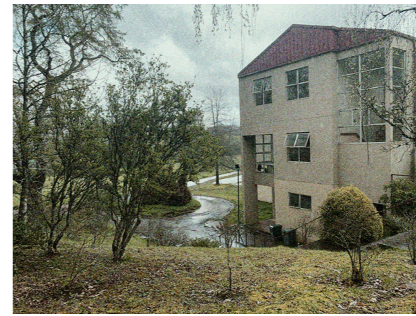
Fig. 34. Lateral del edificio Nahmias Universidad Austral de Chile. FUENTE: Cristián Bachmann, 2022.
