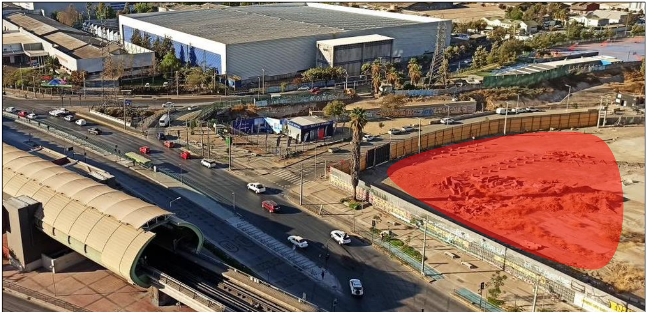
Imagen N° 05: Esquina Vicuña Mackenna con Avenida Quilín, se aprecia estación de metro Carlos Valdovinos.
