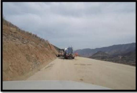
Ilustración 8._: Fotografía ruta E-315 – Terraplén Dm 5.400 a Dm 5.200
