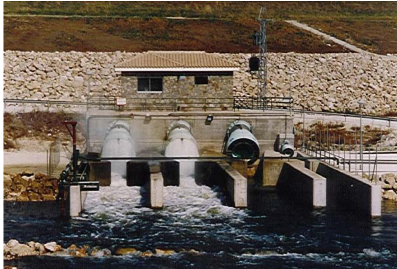
Ilustración 2.12: Fotografía de caseta de válvulas de entrega de aguas en embalse. Fuente original: imagen capturada de internet
