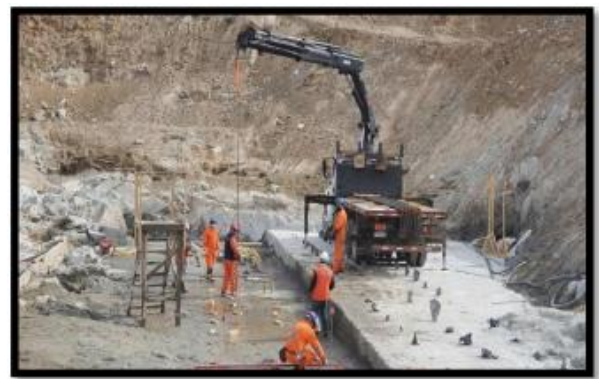
Ilustración 8._: Fotografía Evacuador de Crecida – Vista General
