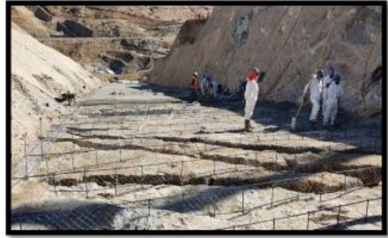
Ilustración 8._: Fotografía plinto valle – Instalación de Moldajes y Limpieza de roca.
