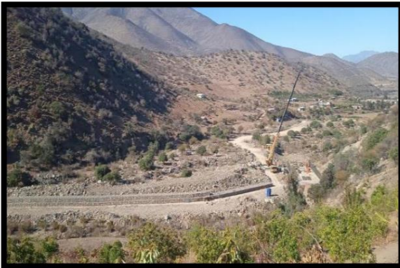
Ilustración 8._: Fotografía Estación Fluviométrica Las Carditas – Construcción Muro de Contención
