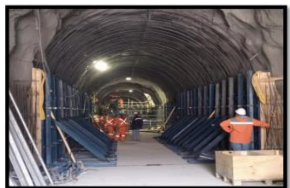
Ilustración 8._: Fotografía Vista general túnel de desvío – Portal de entrada
