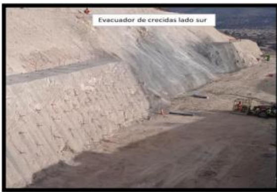
Ilustración 8._: Evacuador de Crecidas – Vista Rápido de Descarga
