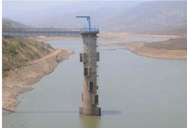
Ilustración 2.7: Fotografía Obra de Toma, Represa de Canoabo, Venezuela. Fuente original: imagen capturada de internet
