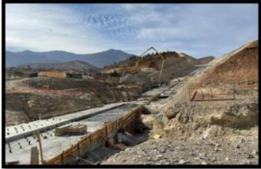
Ilustración 8._: Fotografía sector Muro Principal – Vista General
