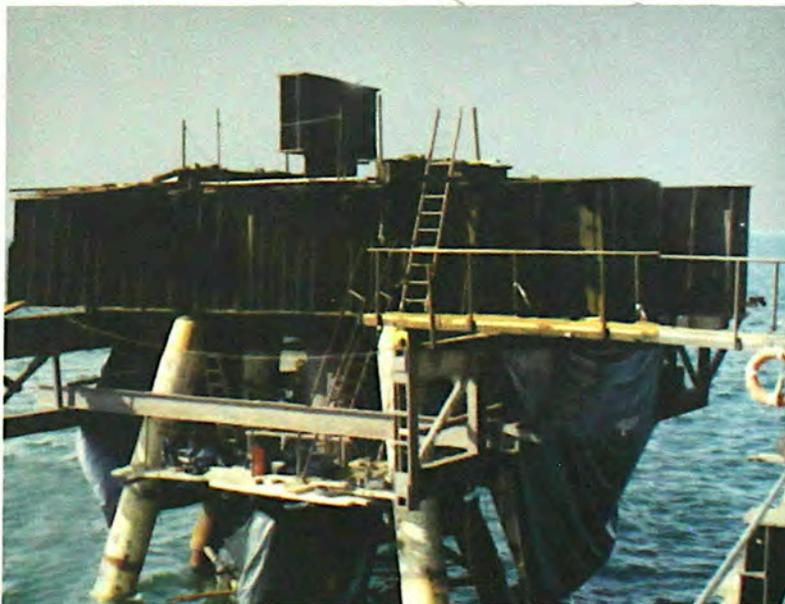
Las cargas máximas aplicadas sobre los pilotes de prueba fueron 900 ton en tracción y 1300 ton en compresión.
