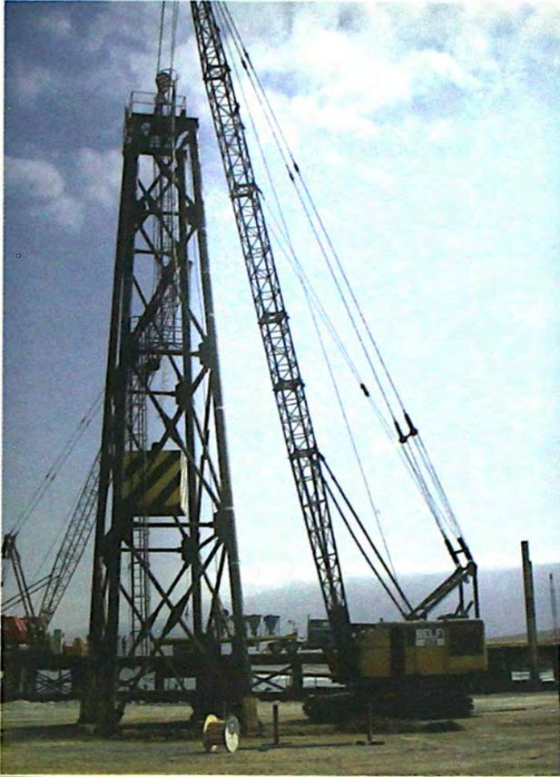
La hincada de los pilotes fue ejecutada entonces con una grúa de 150 ton montada sobre los mismos pilotes que componen el muelle. A pesar de la gran longitud de los pilotes (55 m), se diseñó un método constructivo que permitía hincarlos en su longitud completa, sin efectuar empalmes en terreno.
