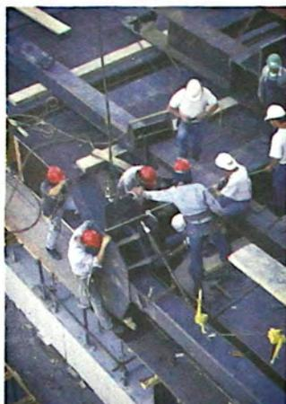
Los cables de la viga postensada debían anclarse en la cara exterior del tirante, por lo cual fue necesario perforar el perfil y pasar el 50% de los cables a través de él, mientras que el 50% restante se abrió en torno al perfil.
