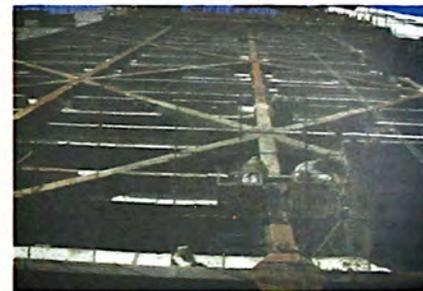
muchos casos especificar las secuencias de armado y soldadura, debido a la complejidad y dimensiones de estos. En el caso de los nudos y anclajes insertos se los sometió adicionalmente a un proceso de aliviación de tensiones.
