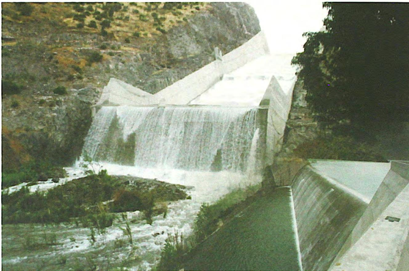
El evacuador de crecidas está completamente revestido con hormigón armado, con anclajes sistemáticos a la roca. La sección hidráulica fue diseñada para soportar una crecida afluente de  $2.500 \text{ m}^3/\text{s}$ , verificada a  $3.300 \text{ m}^3/\text{s}$ , correspondientes a las crecidas de periodo de retorno 1:10.000 años y *máxima probable*, respectivamente.
