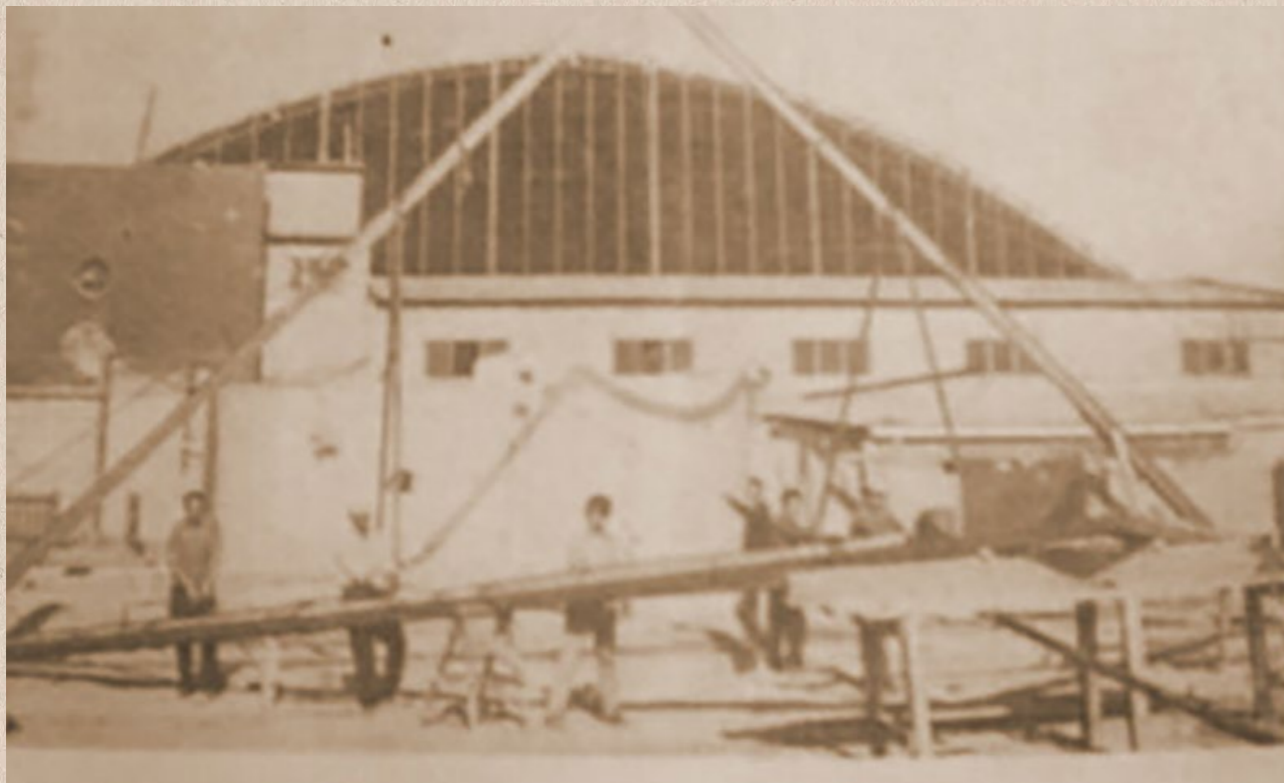
Reconstrucción de la Iglesia Sagrado Corazón en el año 1970, se puede apreciar parte de la estructura de la cubierta del mercado, fachada norte. Fuente: Tocopilla y su Historia, blog de Damir Galaz-Mandakovic.
