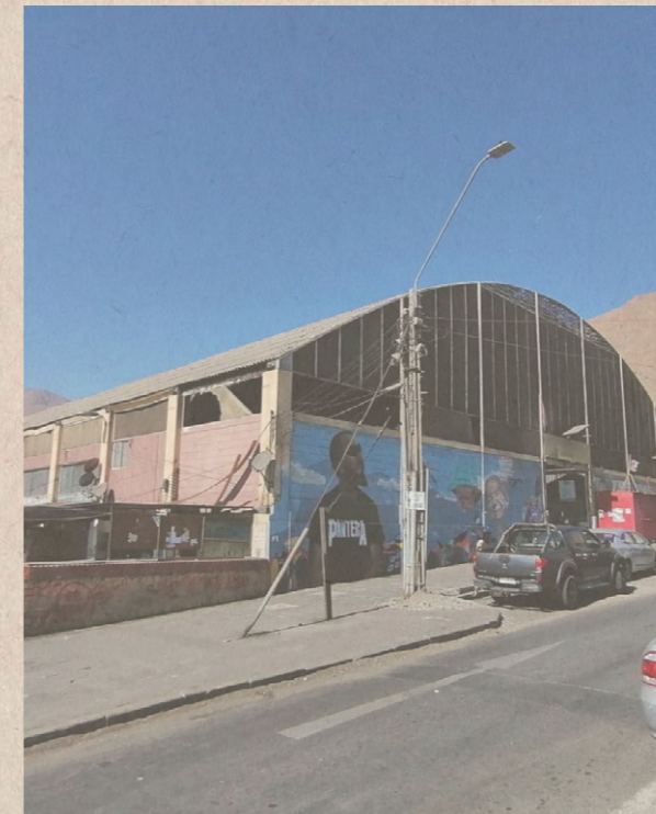
Vista de fachadas sur y poniente. Archivo personal
