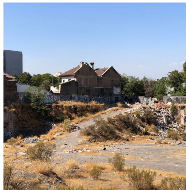
Fig 51. Vista interior hacia el norte. Elaboración propia
