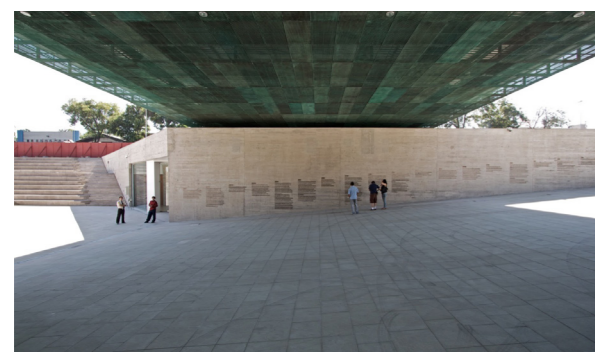
Fig 61. Fotos exteriores. Extraídas de www.archdaily.cl
