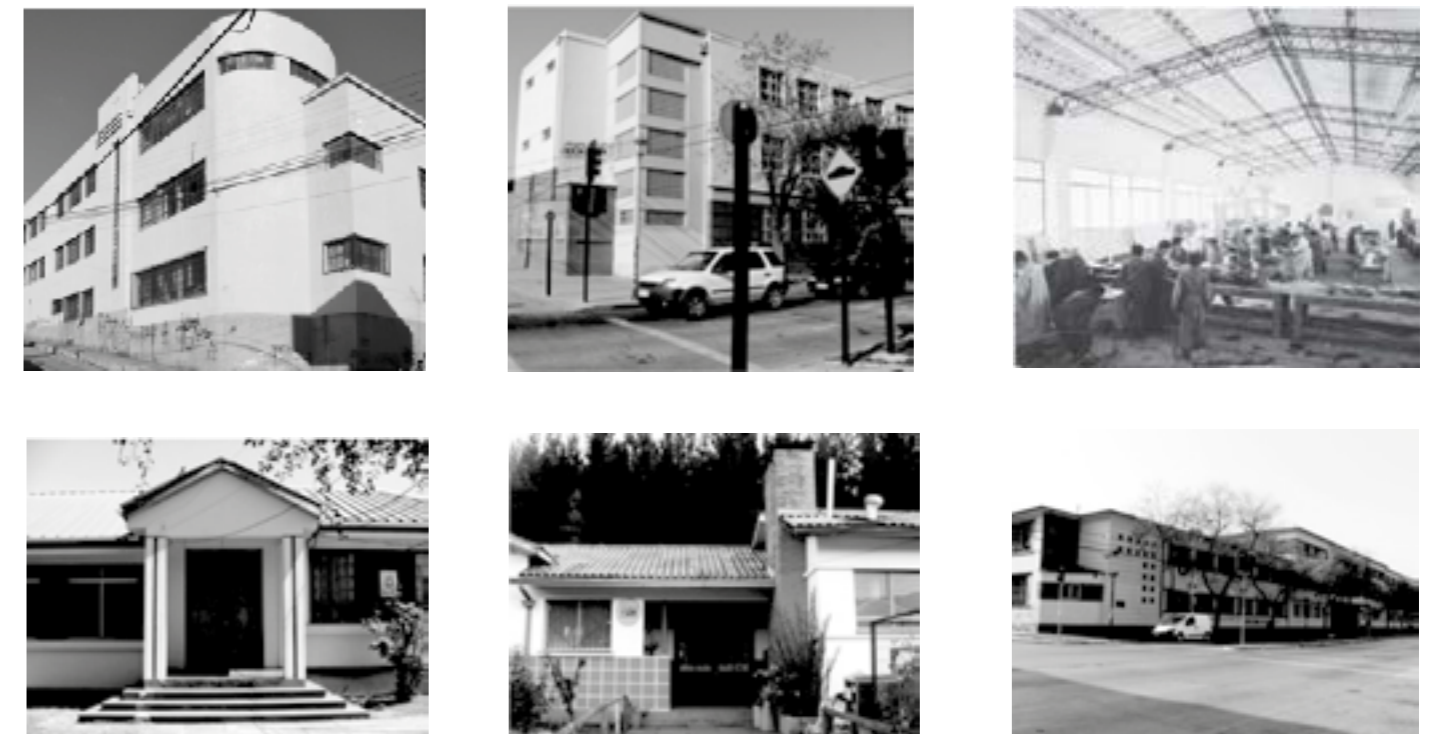
Fig. 10: Conjunto de imágenes de la infraestructura escolar en Chile a lo largo del siglo. Fuente: elaboración propia
