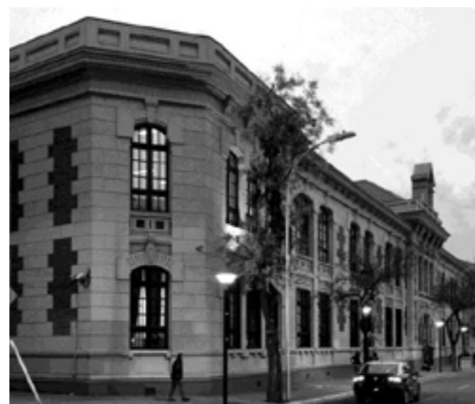
Fig. 4: Escuela Salvador Sanfuentes, Santiago, 1920 (Rivera Notario) Fuente: Evolución de los sistemas constructivos en la arquitectura escolar chilena del siglo XX de Claudia Torres Gilles
