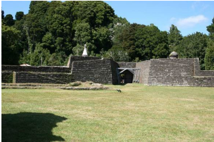
Figura 3: Muro de Acceso, Castillo de Mancera. Fuente: Cerda B., A. y Cerda B., G., s.f., s.p.
