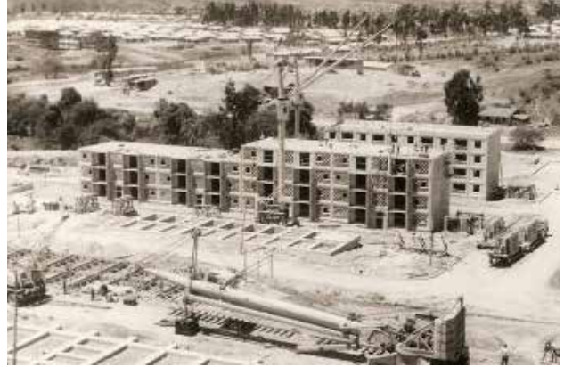
Edificio 1020. Fuente: MINVU (2005). Chile un Siglo de vivienda y Barrio. Santiago, Chile. https://www.uchile.cl/noticias/165033/terremoto-del-71-una-experiencia-de-reconstruccion-y-re-activacion
