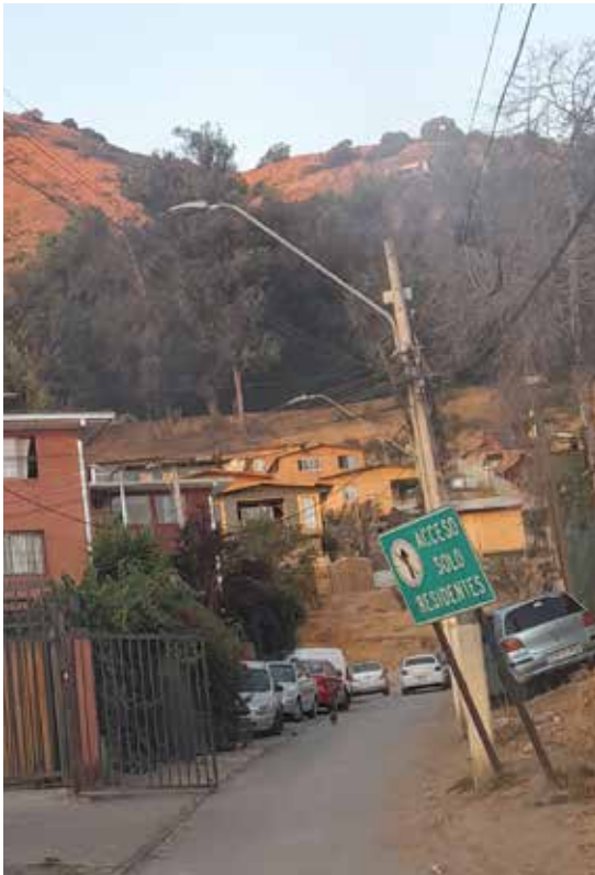
Viviendas sociales Las Canteras
