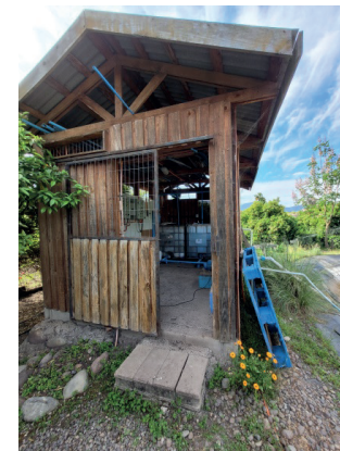
Imagen n°18: Bodega de generadores
