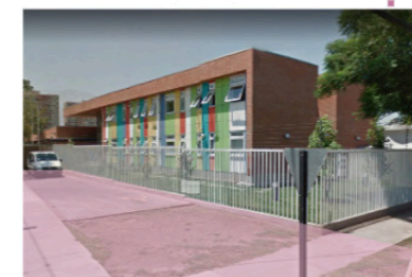
Acera calle principal
