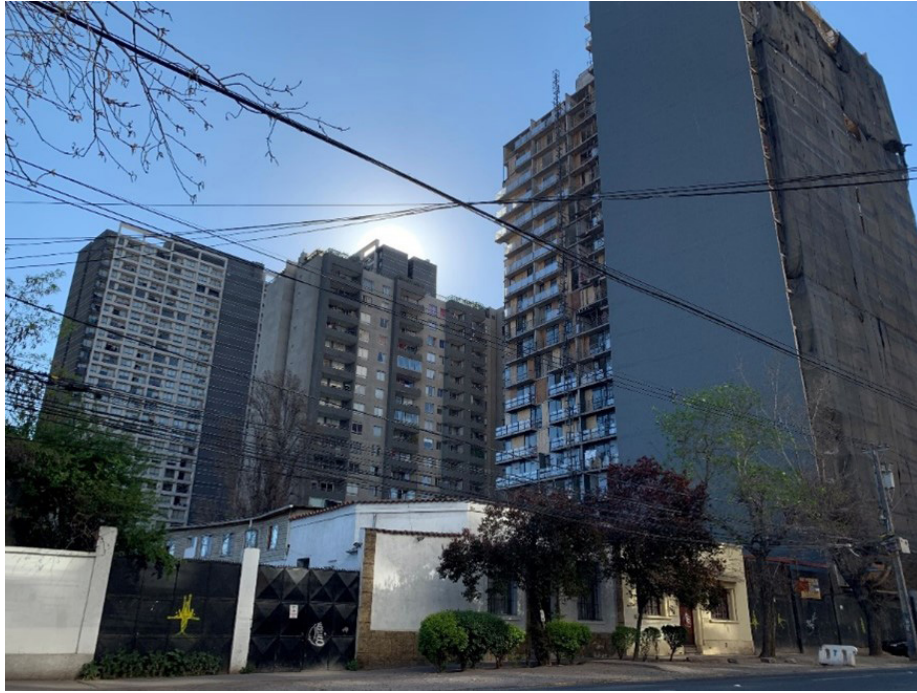
Figura 1. Casas históricas del barrio emplazadas bajo los conos de sombra proyectados de los edificios hiper-densos; fotografía tomada en calle Toro Mazote, entre calles Coronel Souper y Av. 5 de Abril. (Fuente: Elaboración propia)
