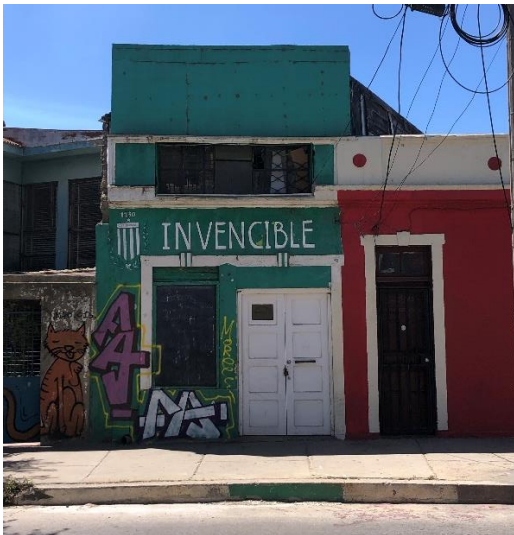
Figura 8. Tipología de viviendas en tramo Av. Alemania. Elaboración propia.
