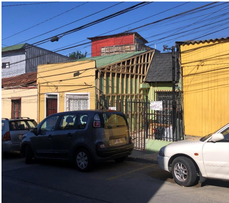
Figura 22. Vivienda con sistema constructivo de adobe en proceso de intervención con madera ubicada en el tramo Av. Alemania, cerro Yungay, Valparaíso. Elaboración propia.
