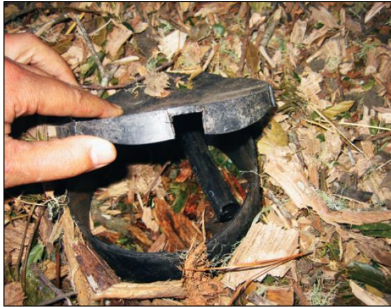
Figura 7-9: Parte superficial de la caja para válvulas con la tubería de ½" (adaptado de Greywater Action, 2016).
