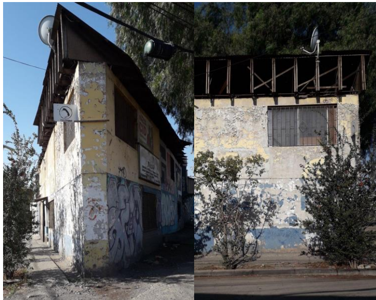
Figura 41. Muro antes de la ejecución de mural 1 Las Chacras
