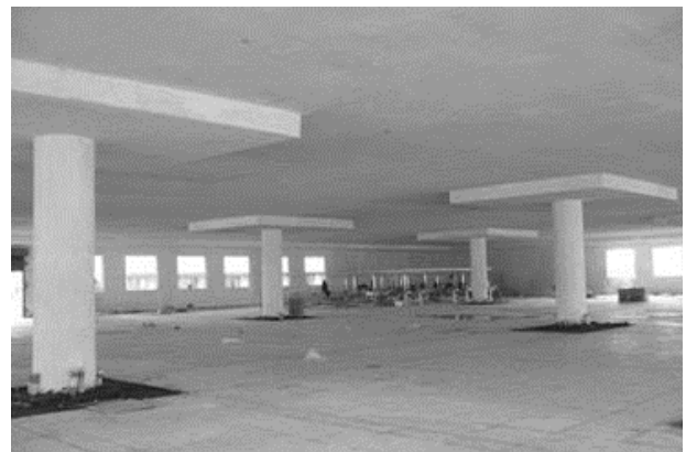
Losa Postensada apoyada sobre Pilares y Capiteles
