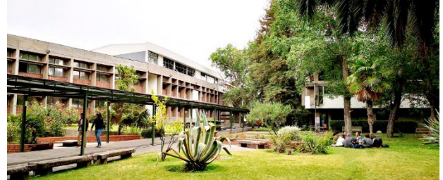
Bloque de Aulas
