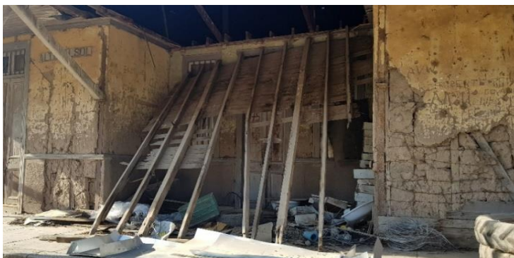
Nota. Estado de conservación de la ex estación de Altovalsol. [Fotografía] autoría propia, 2022.
