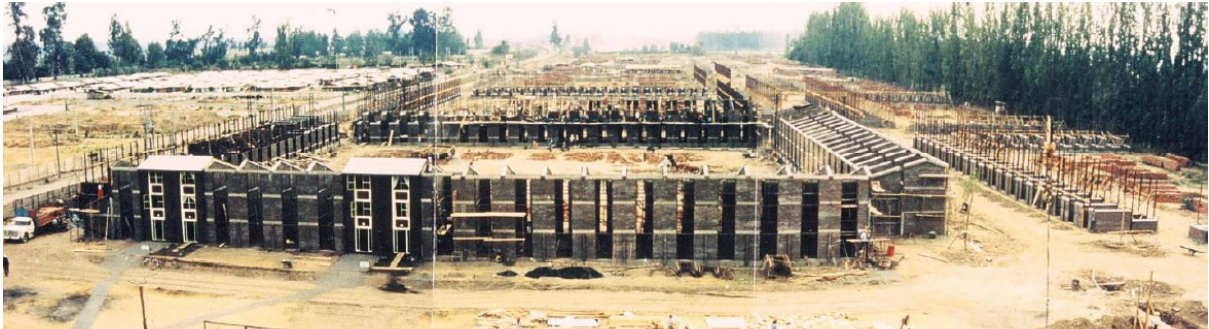
Figura 5: Construcción Villa Los Sauces ,Fuente: Francisco Vergara
