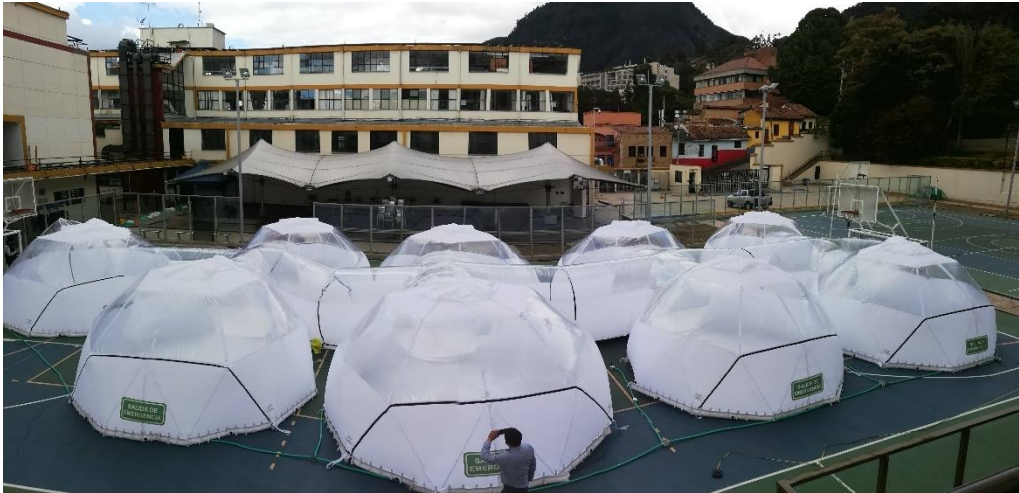
Figura 23: Sistema de domos geodésicos Unidad de Aislamiento Epidemiológico (Unidad de Aislamiento Epidemiológico Portátil. 2020).
