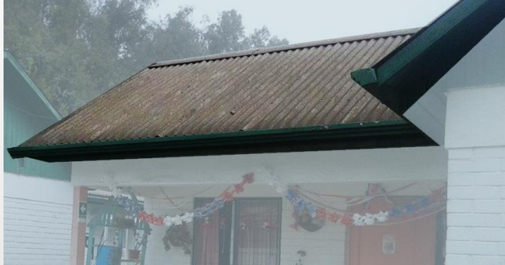
Figura 38: Techo no ventilado
