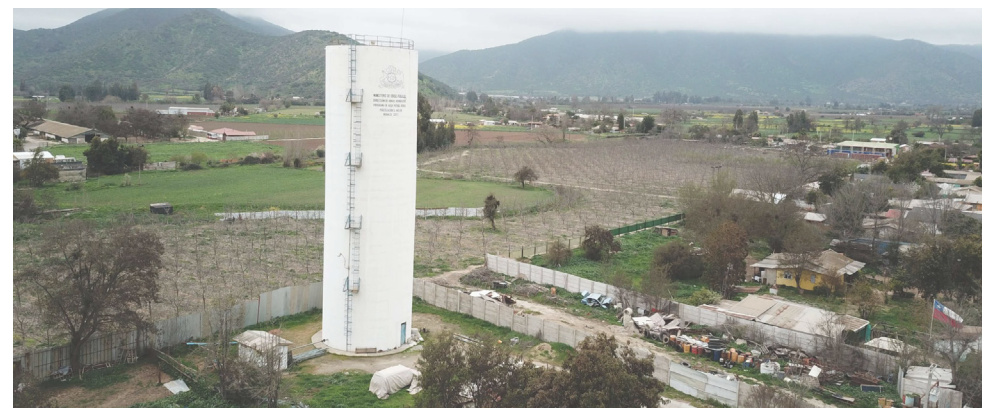
Imagen N°3: Torre de APR.
