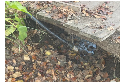
Imagen N° 44: Eliminación de Aguas Grises.
