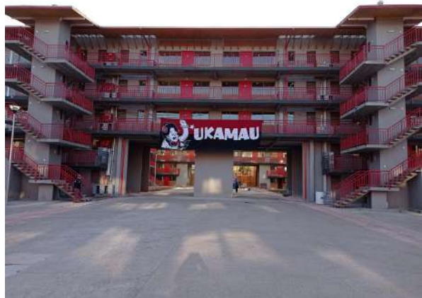
Figura 18. Vista interior del Conjunto Barrio Maestranza.
