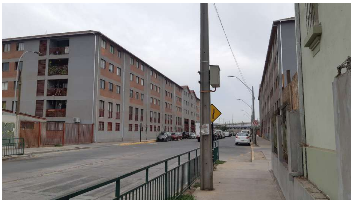
Figura 35. Vista del conjunto desde calle Ramón Subercaseaux.
