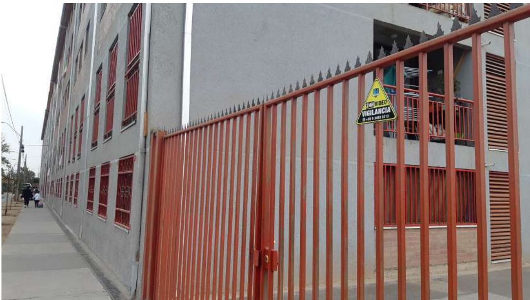
Figura 32. Accesos cerrados y con cámaras de vigilancia.
