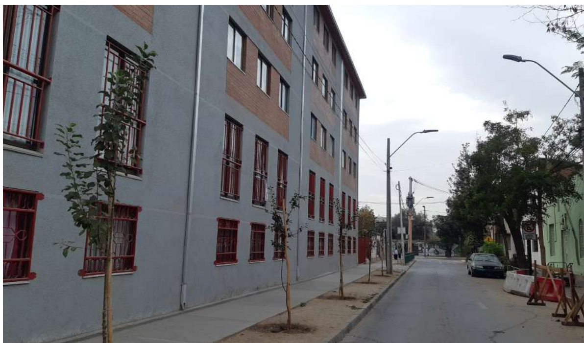
Figura 36. Vista del conjunto desde pasaje Santiago Watt.
