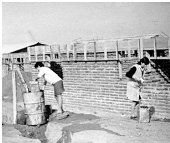
Figura 12. Mujeres y hombres construyendo sus futuras casas, 1967.
