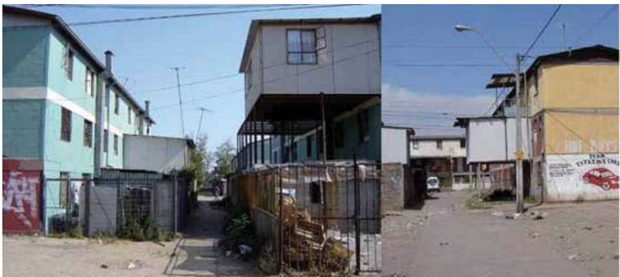
Figura 14. Vivienda social producida en el período de dictadura con ampliaciones informales.
