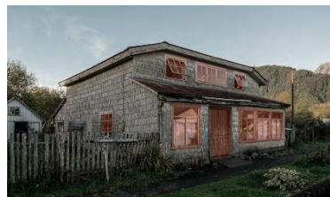
(a) Volumen de dos pisos y vanos inferiores
