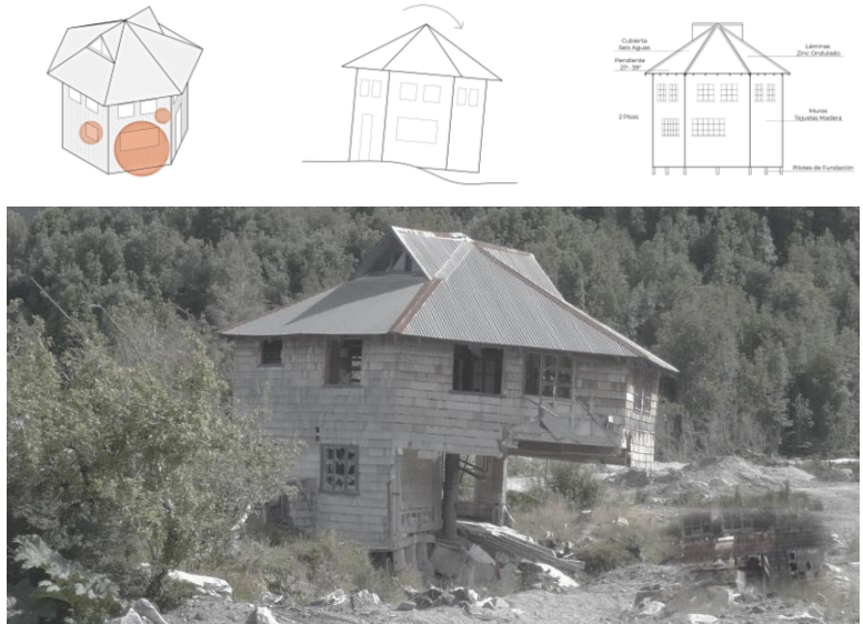
Figuras 15. Catastro de daños observados Vivienda A
