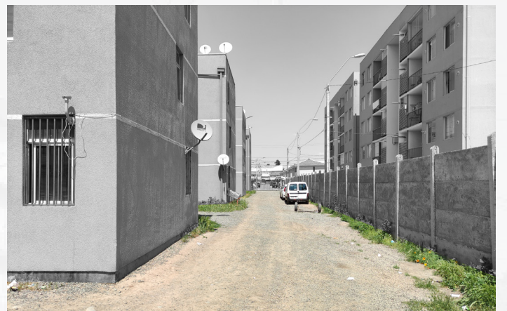
Fotografía 14: Vía de evacuación usada como estacionamiento. Fuente: Autoría propia.
