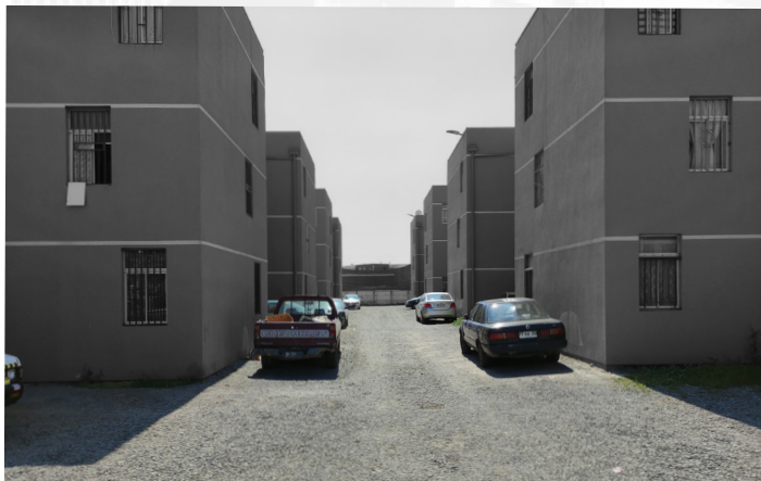
Fotografía 13: Vacio central de estacionamientos, entre departamentos. Fuente: Autoría propia.
