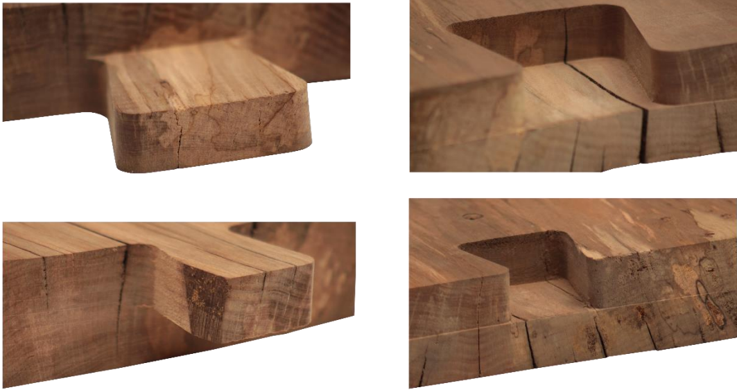
Figura 31: Detalle rotura y crecimiento de las grietas de la albura en el canelo semi-húmedo. Fuente: Elaboración propia.
