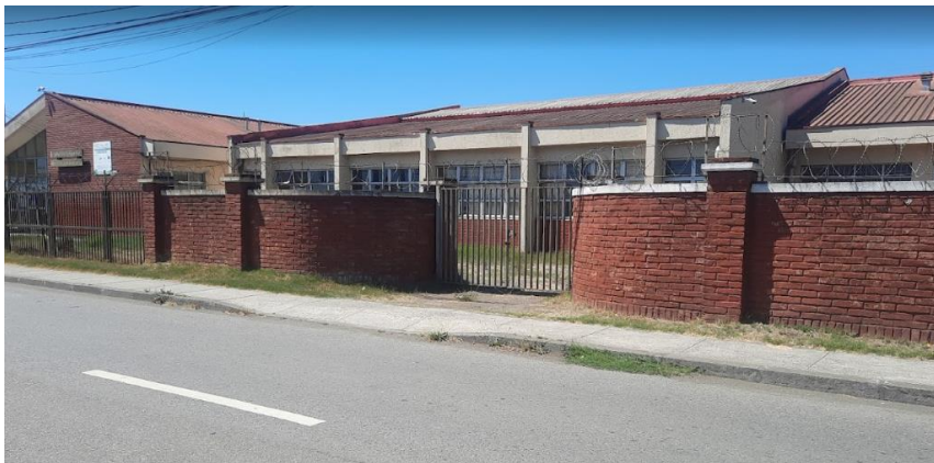
Figura 1: Lagos, C. Colegio Galvarino [Fotografía online Google Street].
