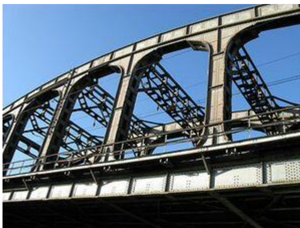
Figura 3: Meuris, P. (s.f). Puente con vigas Vierendeel [Fotografía]. 9
