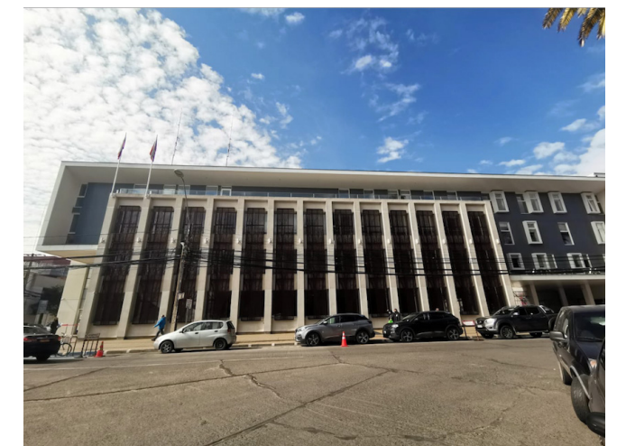
Fig. 21: Patio de las Artes, Curicó Fuente: Fotografía Tomás Valladares
