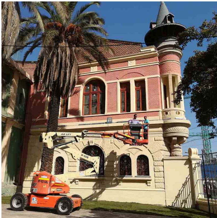
Fig.31 Después restauración fachada Ex cervecería Ebner Fuente: https://www.mallbarrioindependencia.cl/cerveceria-ebner/
