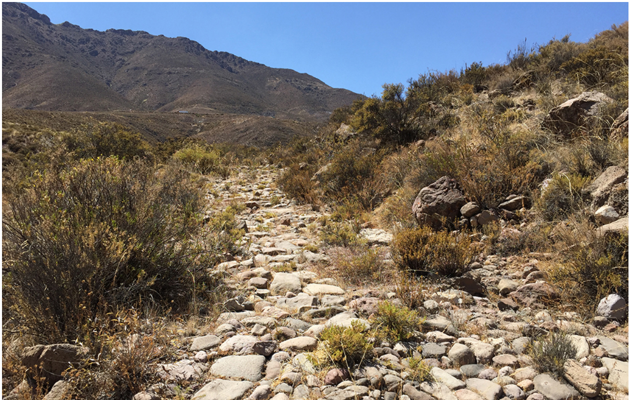
Fig. 16 Camino empedrado en Socoroma Sur, subtramo Putre Zapahuiria, Región de Arica y Parinacota.
