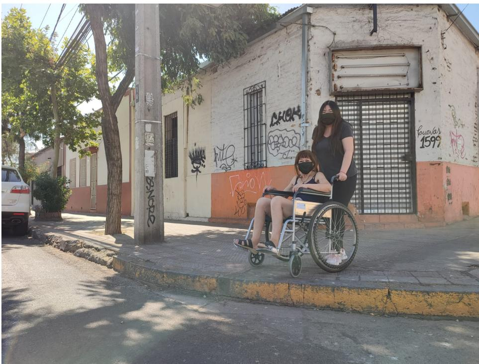
Figura2: Transito de una silla de ruedas dificultado por la falta de rebaje de calle en esquina Pedro Lagos.
