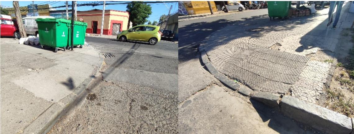
Figura21: Fotografías ejemplificadoras de rebajes fuera de norma.
