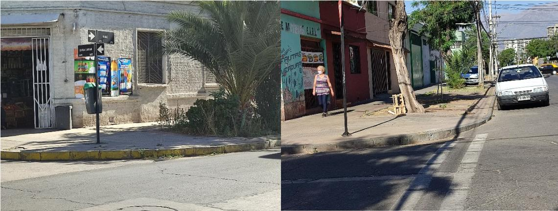
Figura20: Fotografías ejemplificadoras de esquinas sin rebajes.
