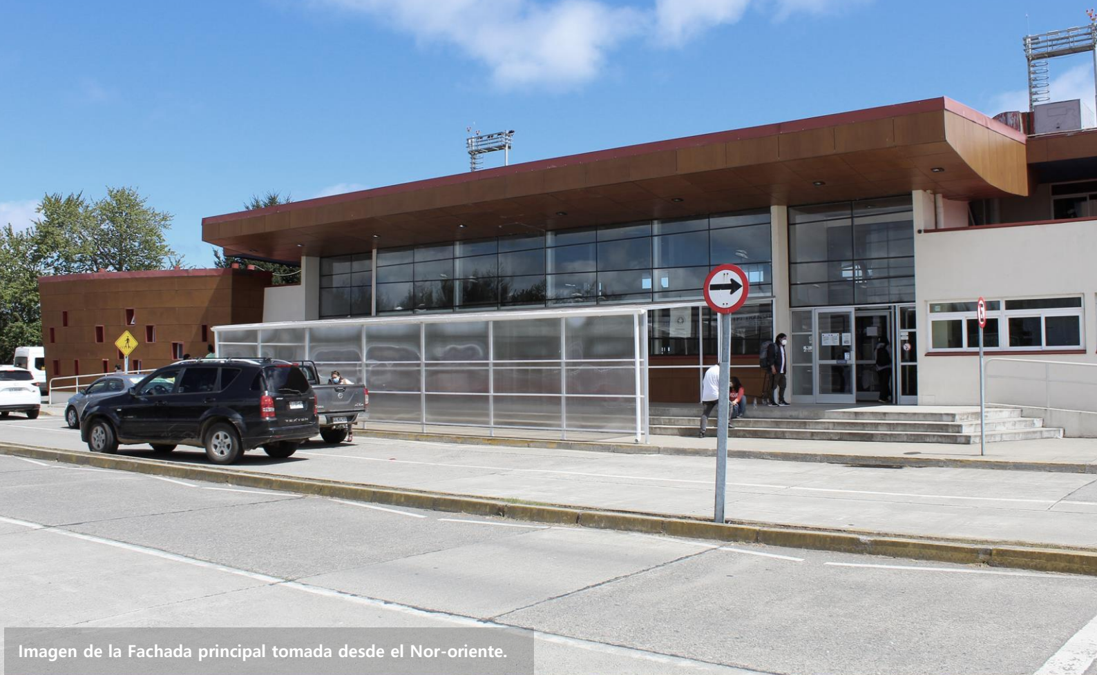
Figura 54: Imágenes de la fachada de la terminal de pasajeros del Aeródromo Pichoy, Fuente: (Ambas) Elaboración Propia.
