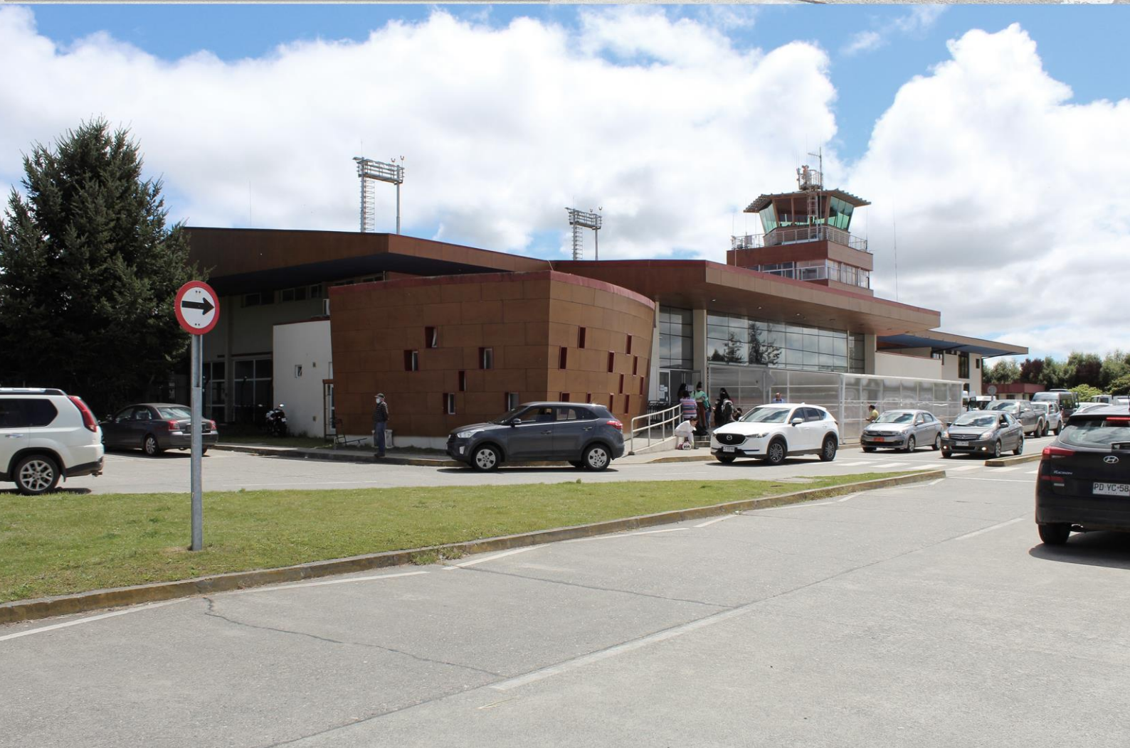
Imagen de la Fachada principal tomada desde el Sur-orient.
