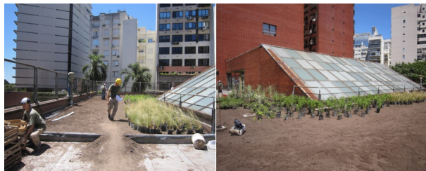
Imagen 41/42: Instalación de sustrato Fuente: Gobierno de la Ciudad de Buenos Aires
