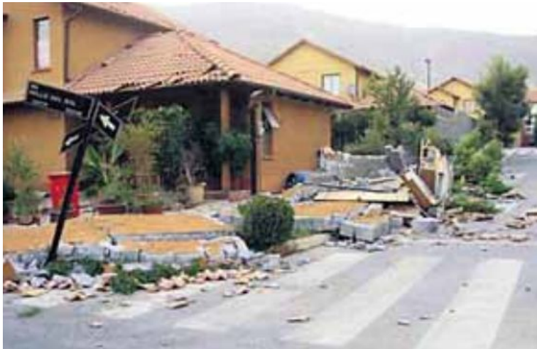
Foto 3: Colapso de muro en “Ciudad de los Valles” Fuente: Archivo Diario La Segunda
