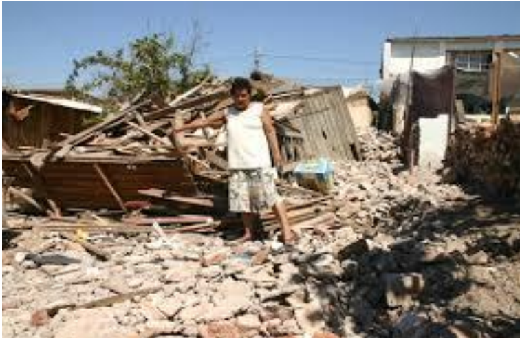
Foto 2: Derrumbe vivienda en casco histórico Pudahuel Fuente: Archivo Diario Tropezón
