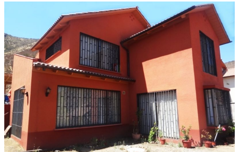
Foto 13: Fachada Norte casa Ciudad de los Valles
