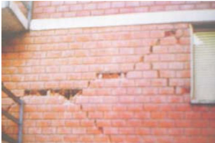
Foto 6: Albañilería armada parcialmente rellena
