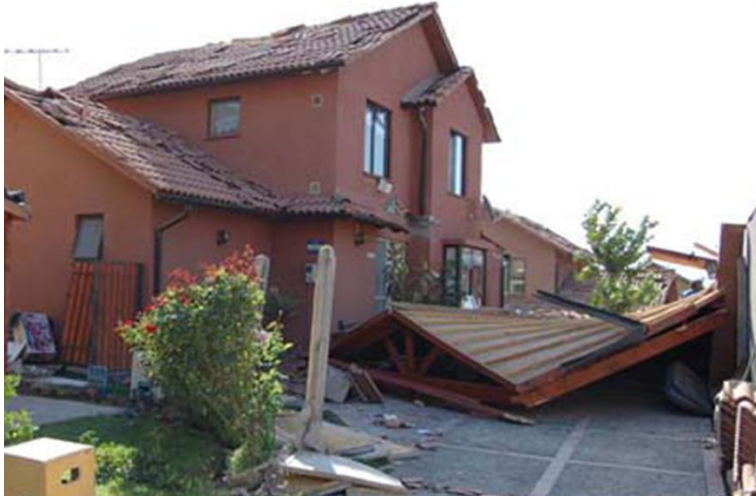
Foto 10: Daños visibles en condominio Ciudad de los Valles Fuente: Departamento de Gestión de Riesgos
