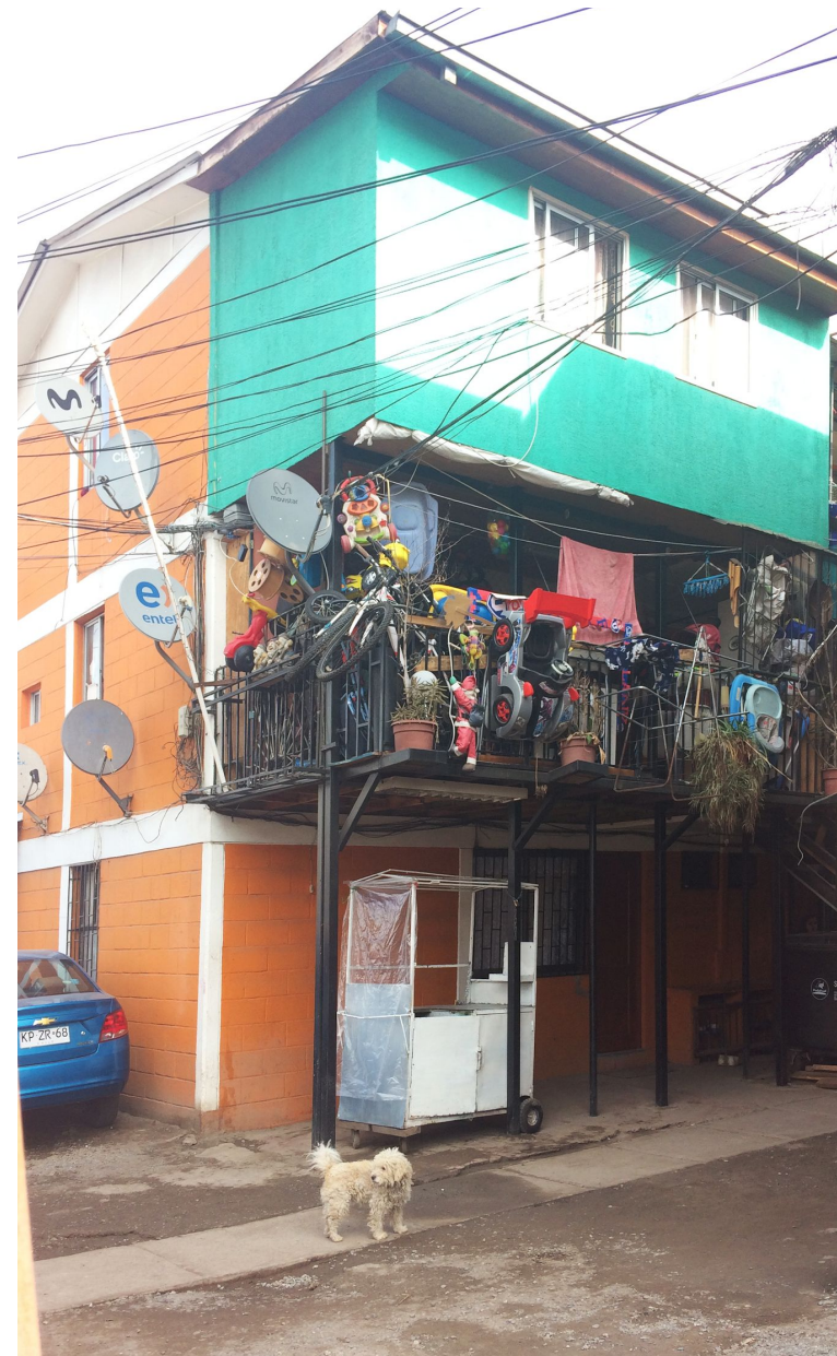
Foto 11: Ampliación irregular en Villa Roberto Matta
