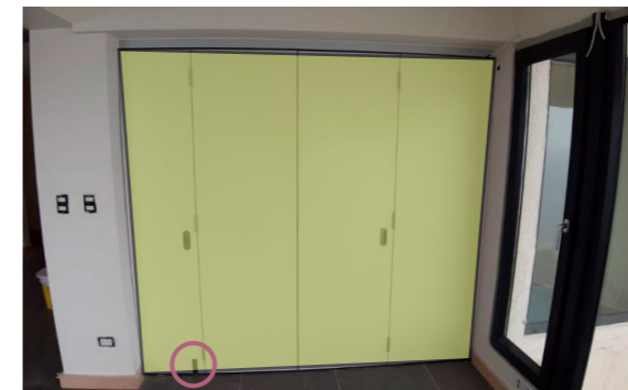
El panel fijo con pivotes tiene un seguro a suelo para evitar su movimiento cuando sea requerido.
