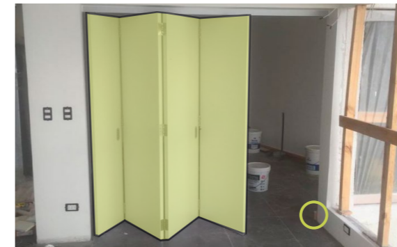
Al guardapolvo del muro continuo al tabique le dan unos cm más de largo para formar una especie de tope para evitar el movimiento del panel hacia ese sentido.
