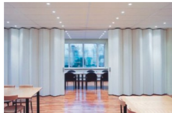
Fig. 26: Tabiques plegables con forma de acordeón. Fuente: Guía de Construcción Sostenible.Bruseles (2017) Dispositivo | Tabiques móviles y acústicos
