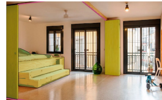
Espacio abierto correspondiente a la zona del dormitorio, conectándose con las zonas comunes del departamento. Paneles corredizos monodireccionales con rieles superiores e inferiores .
