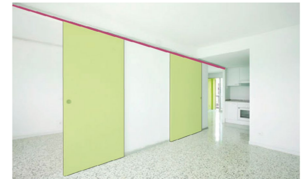
Su desplazamiento es a través de un riel superior ubicado en el eje longitudinal central de la vivienda.
