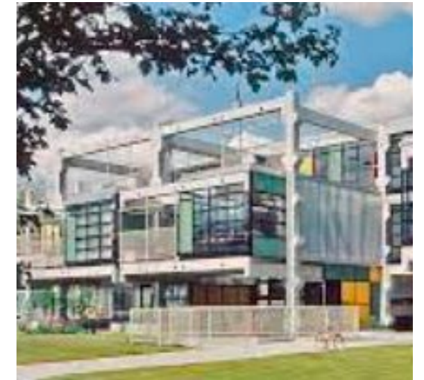
Fig. 6: Genter Strasse, Otto Steidle, consiste en una estructura prefabricada que permite el desarrollo de la vivienda según el usuario. Fuente: Otto Steidle (2020)
