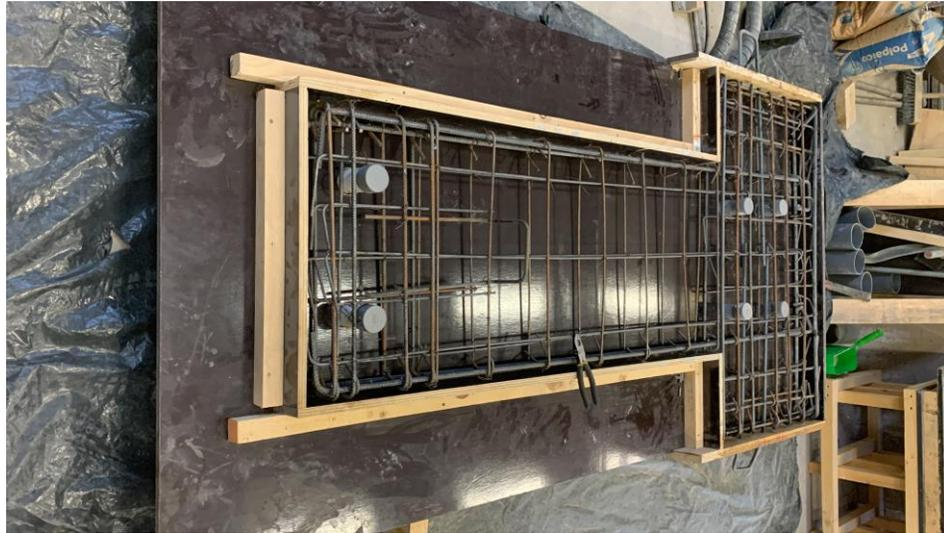
*Figura 3.9 Moldaje y Enfierradura.*
