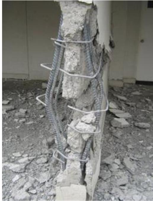
*Figura 1.1 Falla de muro por falta de detallamiento de borde.*
