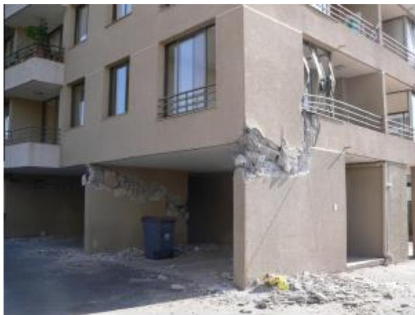
Figura 2.2 Típica falla de corte en muros. (Massone, 2013).
