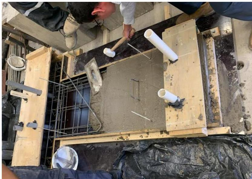
*Figura 3.13 Vertido y vibrado del hormigón.*
