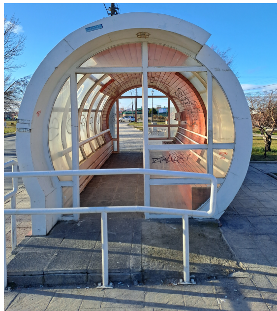
(c) Interior de refugio cubierto casi por completo
