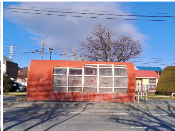
(b) Refugio cubierto casi por completo
