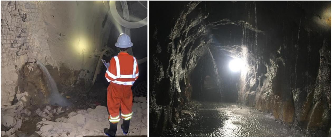
**Figura 21: Ejemplo de drenajes a través de perforaciones dentro de una galería**
