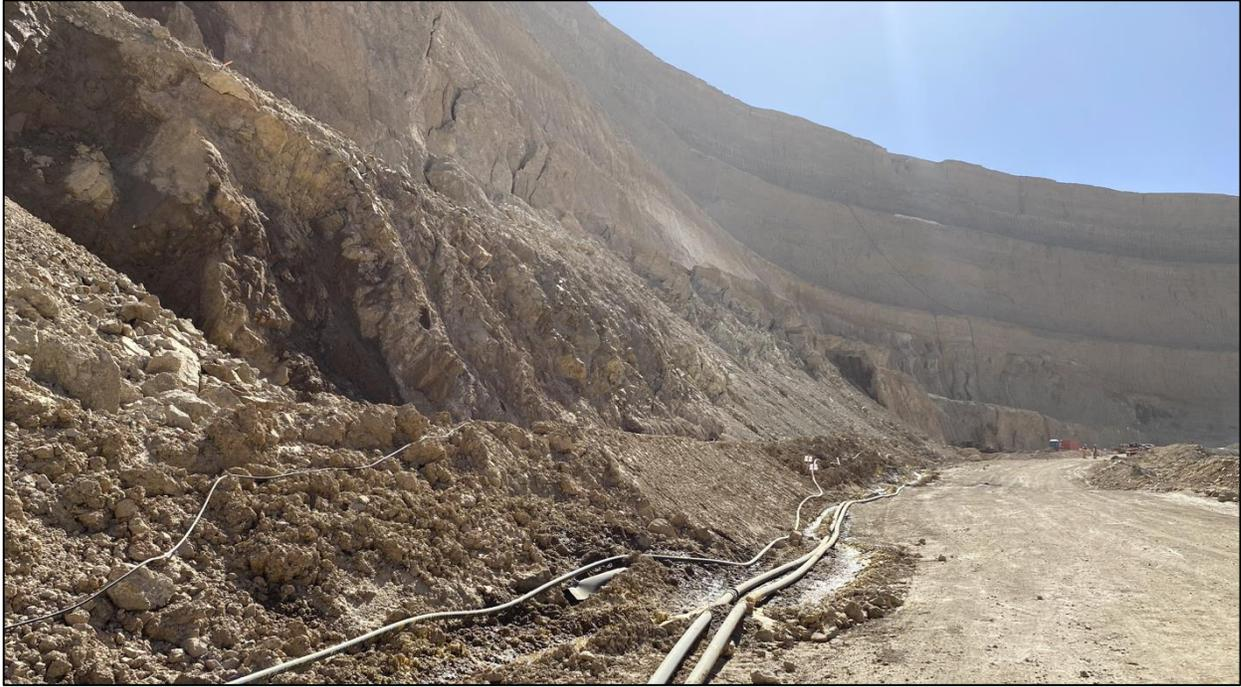
**Fotografía 1: Sector con afloramientos de agua subterránea donde ya no es posible ingresar maquinaria de perforación por compromiso de estabilidad del talud (mina en el norte de Chile).**
