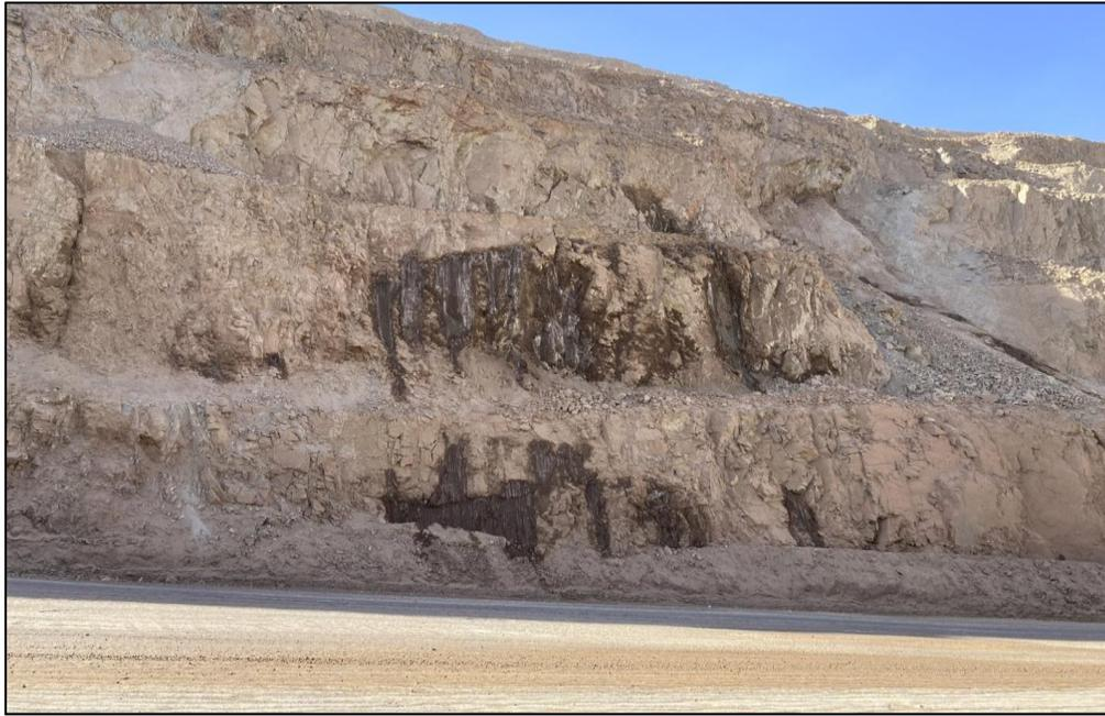
**Figura 2: Ejemplo de agua subterránea que se mueve por una zona de roca fracturada en una mina en el norte de Chile y aparece en el talud (*seepage*)**
