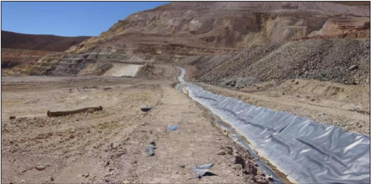
**Figura 15: Ejemplo de desvío de escorrentías superficiales mediante canal perimetral en el borde de un rajo.**
