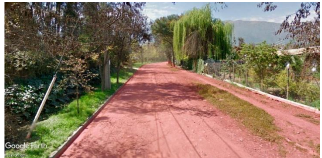
Fig. 8: Vía no pavimentada, calle local Villa Santa Sofía de Lo Cañas. Fuente: Elaboración propia en base a Google Earth.
