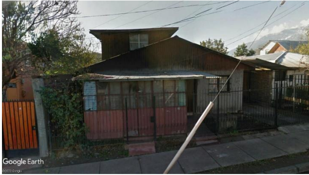
Fotografía de la vivienda. Fuente: Google earth
