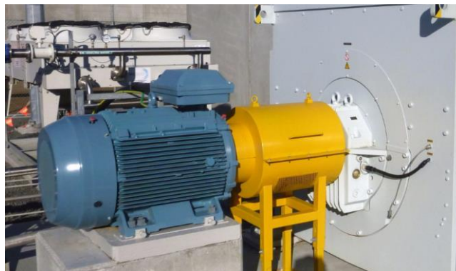
Figura 2.23: Motor pony acoplado al eje de un condensador sincrónico (extraída de [120]).
