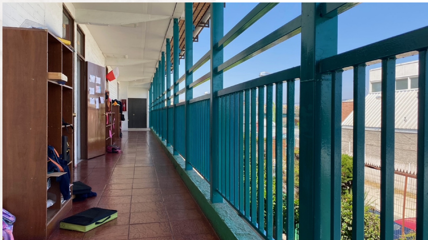
Figura 36. Pasillo segundo nivel Colegio Centenario Vista 2. Elaboración propia,
