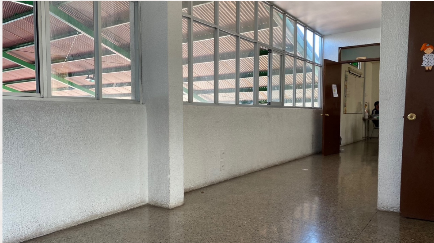
Figura 33. Pasillo segundo nivel Colegio Centenario Vista 1. Elaboración propia, 2022.
