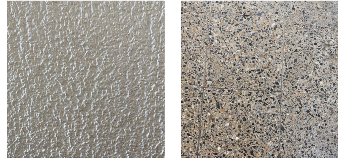
Figura 35. Texturas pasillo segundo nivel Colegio Centenario Vista 1. Elaboración propia, 2022.
