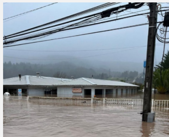
Figura 3. Hospital de Licantén inundado tras desborde del río Mataquito. CNN Chile.
