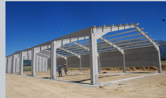
Figura 19. Pórtico Plano Transversal Metro cúbico.
