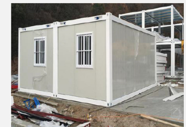
Figura 36. Unidad prefabricada tipo contenedor para la sala de aislamiento National Library of Medicine.
