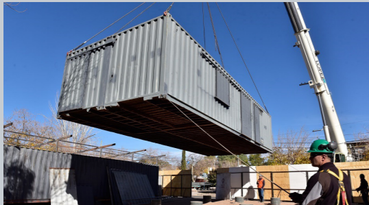
Figura 17. Construcción modular Portal CDT.
