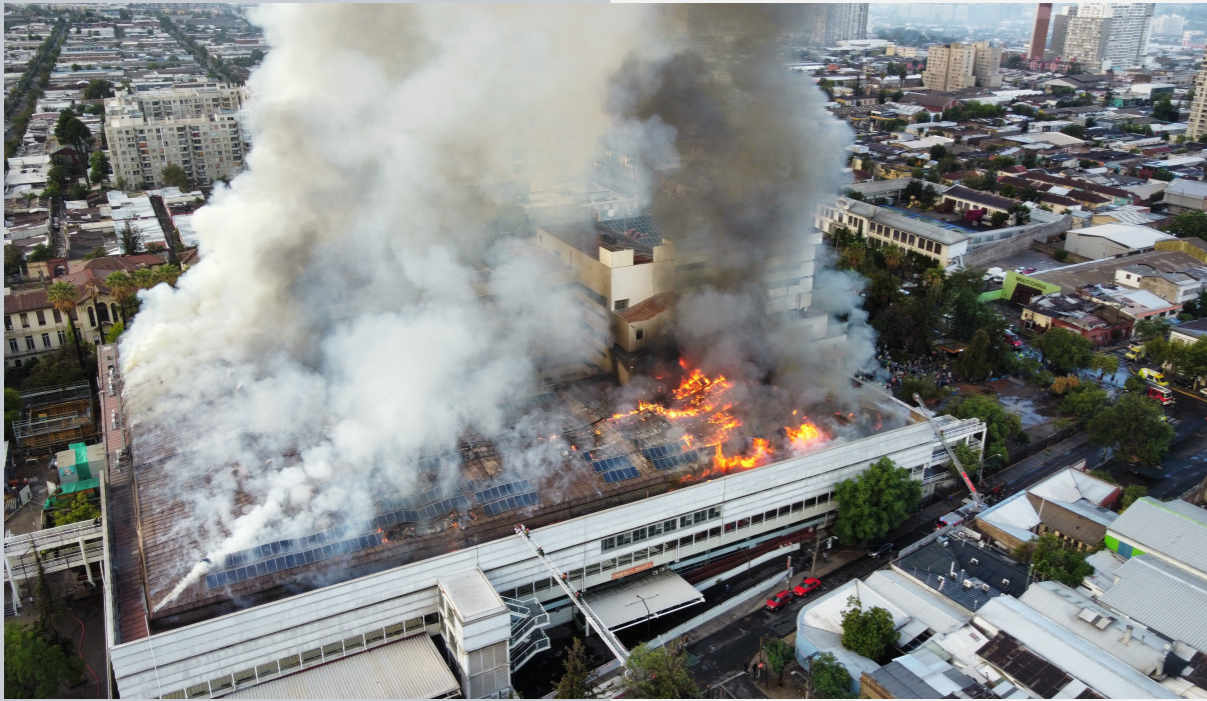
Figura 2. Incendio Hospital San Borja. CNN Chile.
