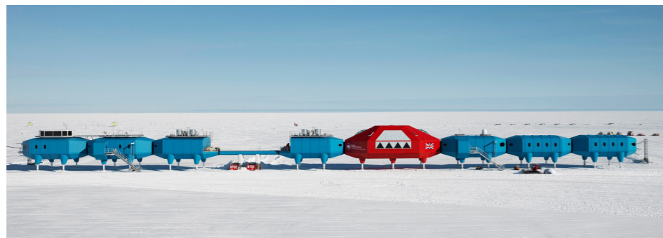
Figura 15: Estación Halley VI. Fuente: https://hbarchitects.co.uk/halley-vi-british-antarctic-research-station/
