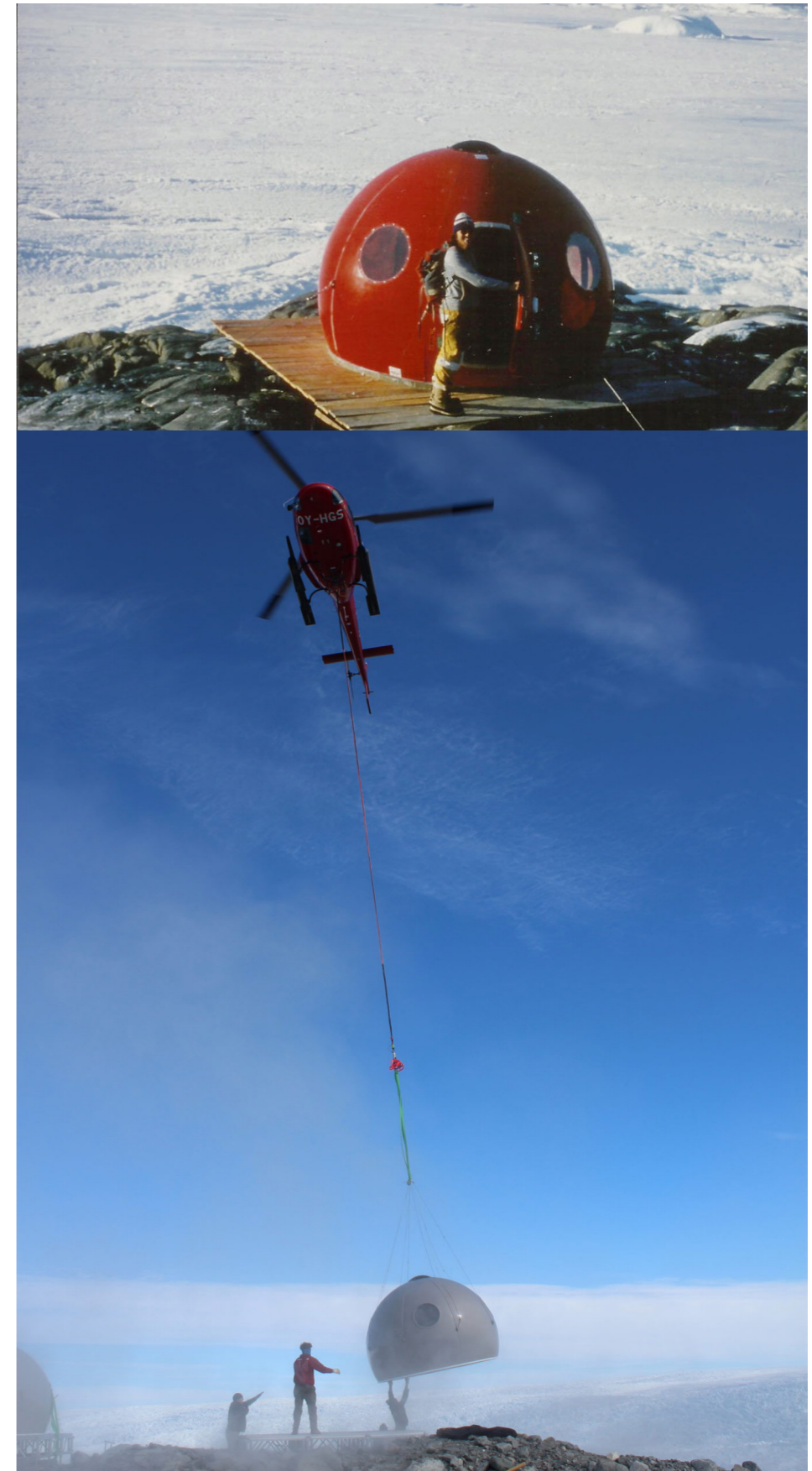
Figura 18: Arriba: Igloo instalado en la Antártica. Abajo: Traslado de Igloo a través de helicóptero Fuente: https://www.australiangeographic.com.au/wp-content/uploads/2022/12/1-1365x2048.jpg
