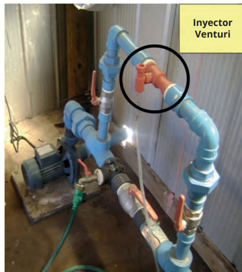
Figura 2.8: Esquema de instalación de inyector Venturi. Fuente: Obtenido de [12].
