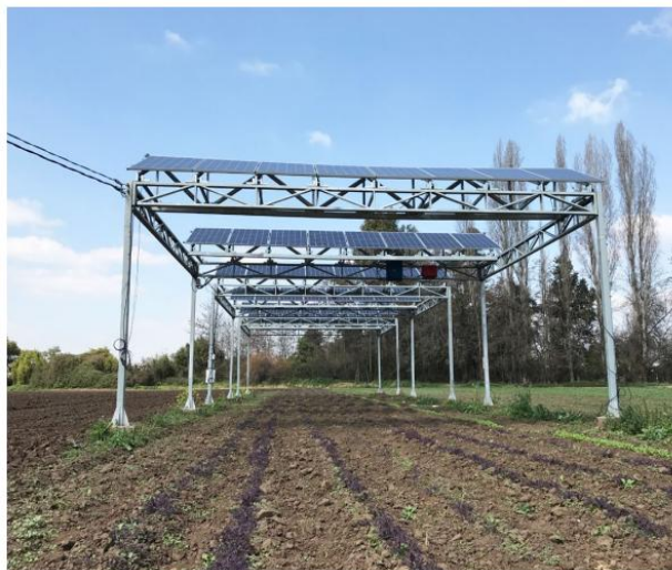
Figura 2.15: Planta piloto de Fraunhofer instalada en Lampa. Fuente: Obtenido de [6].
