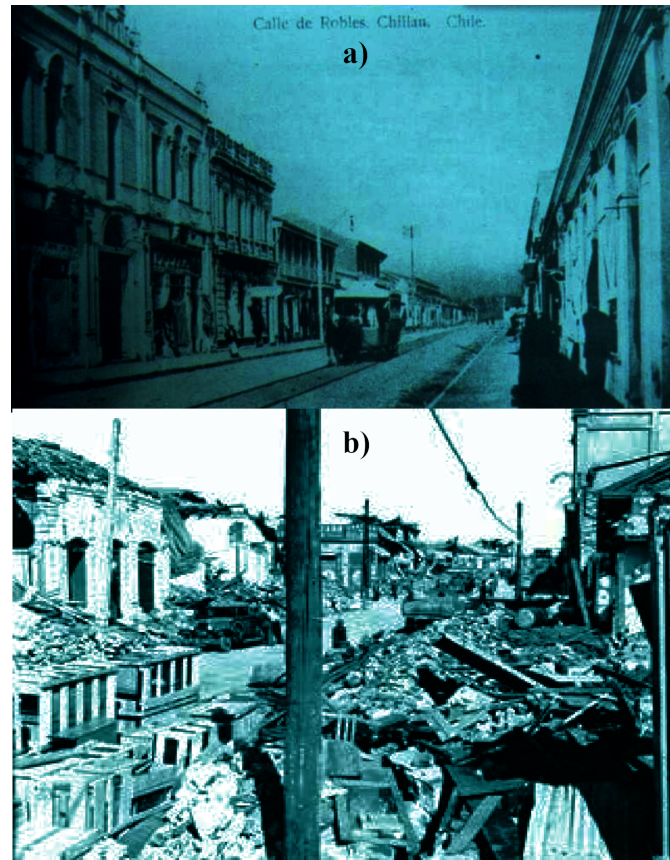
Figura 1.1: Daños causados en las estructuras por el Terremoto de Chillán de 1939. a) Calle Roble, Chillán (1910) de Moya & Sanhueza (2002) y b) Calle Roble, Chillán (1939) de Torrent (2016).
